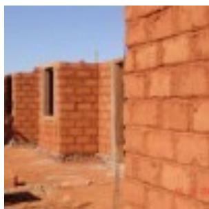
O adobe é um material vernacular usado na construção civil. É considerado um dos antecedentes históricos do tijolo de barro e seu processo construtivo é uma forma rudimentar de alvenaria. Adobes são tijolos de terra crua, água e palha e algumas vezes outras fibras naturais, moldados em fôrmas por processo artesanal ou semi-industrial.
